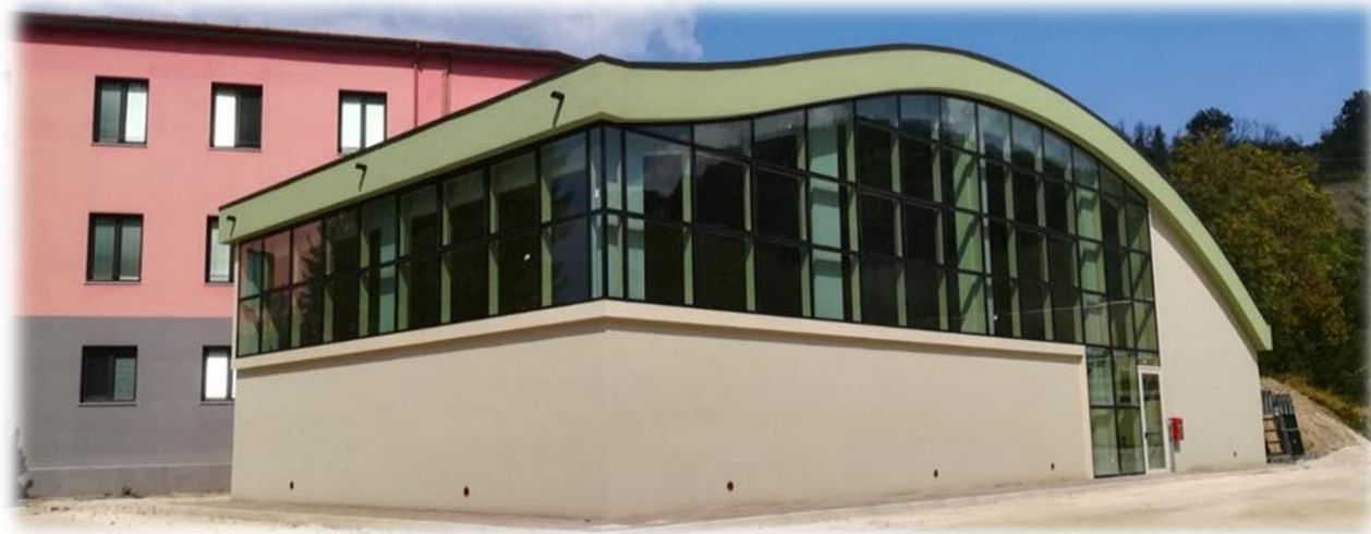
Esterno della nuova palestra (nello sfondo l'edificio di scuola primaria e sec. I grado ristrutturato)
